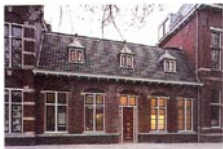
links Exterieur van het rectorhuis van de ambachtsschool in Den Haag. onder Balie met glazen schuifpanelen, met door VASD ontworpen beeldmerk.
